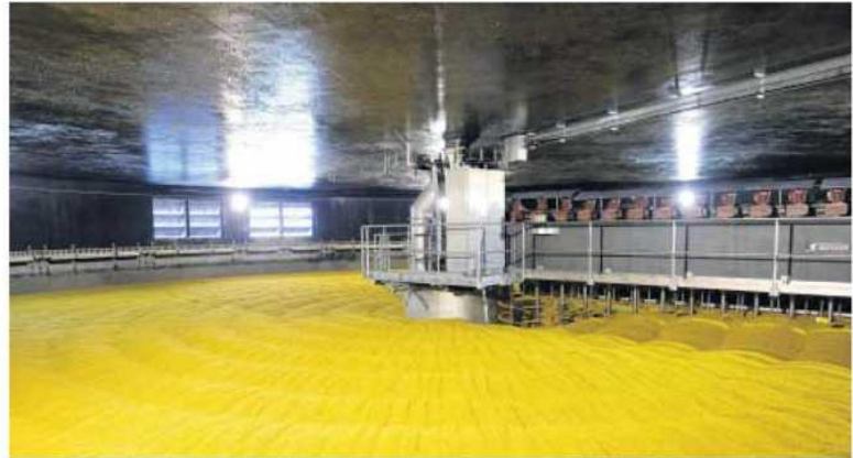
Takto vyzerá sladovňa v Hurbanove po modernizácii. FOTO: HEINEKEN
