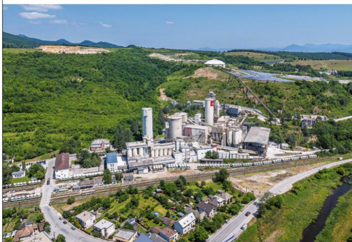
Cementáreň CEMMAC v Hornom Srní vybudovala jednu z najväčších firemných fotovoltických elektrární na Slovensku.
